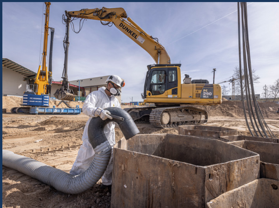
▲ Persönliche Schutzausrüstung und Luftabsaugung
