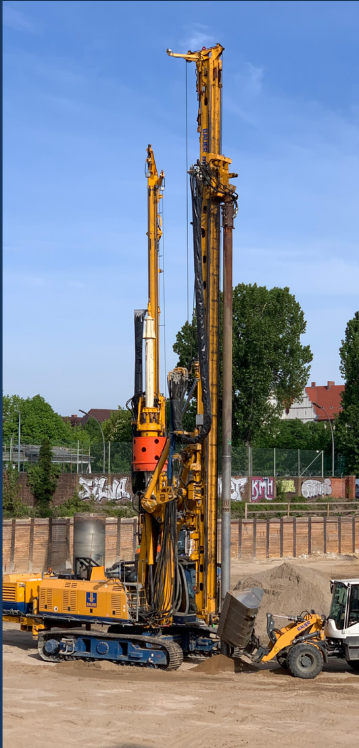
▲ Rütteldruckverdichtung mit Materialauffüllung
