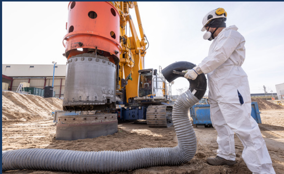
▲ Absaugvorrichtung für den Bohrrohr- rand
