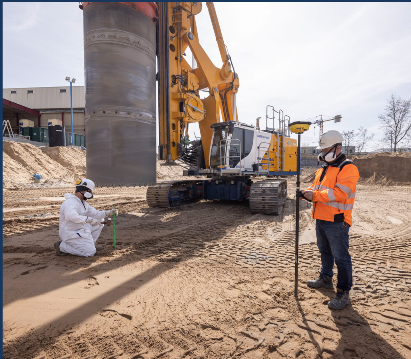
▲ Auspflocken des Bohrpunktes nach satellitengestützter Absteckung
