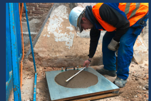
▲ Prüfung der Flüssigbodenkonsistenz
