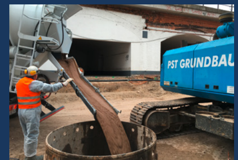
▲ Einbau von Flüssigboden
