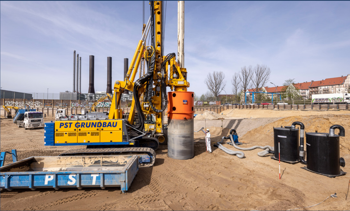
▲ Überblick Bohrpunkt mit Absetzmulde und Luftabsaugung
