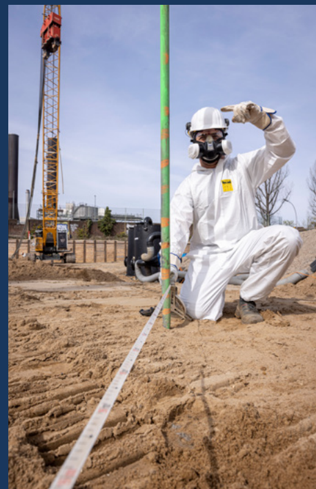
▲ Abstecken einer Bohrreihe
