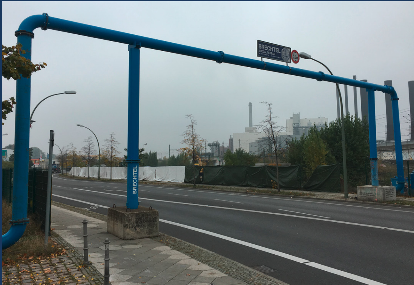
▲ Rohrbrücke zur Ableitung zum Einleitpunkt
