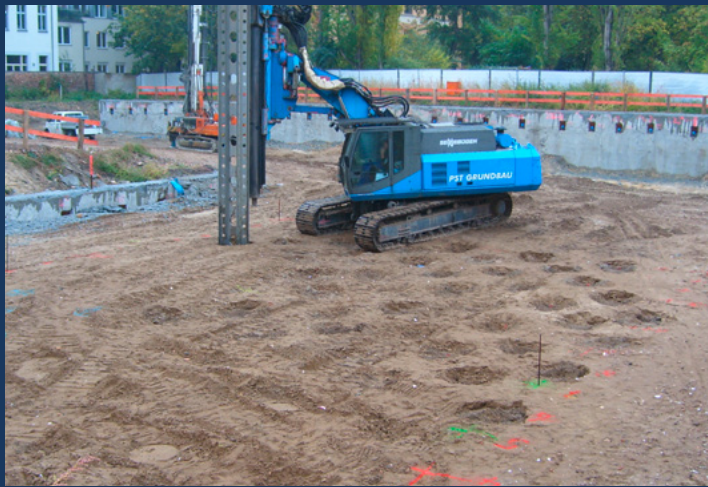
▲ Einsatz der Rüttelbohle
