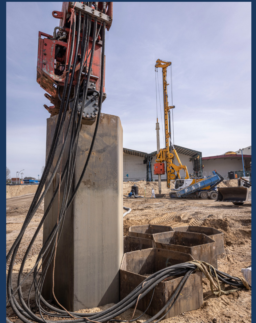
▲ Einbringung eines Wabenelementes
