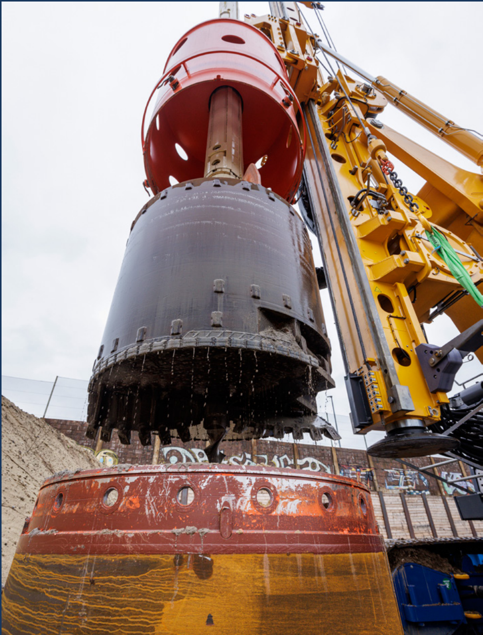
▲ Bohreimer für gesättigte Bodenschichten
