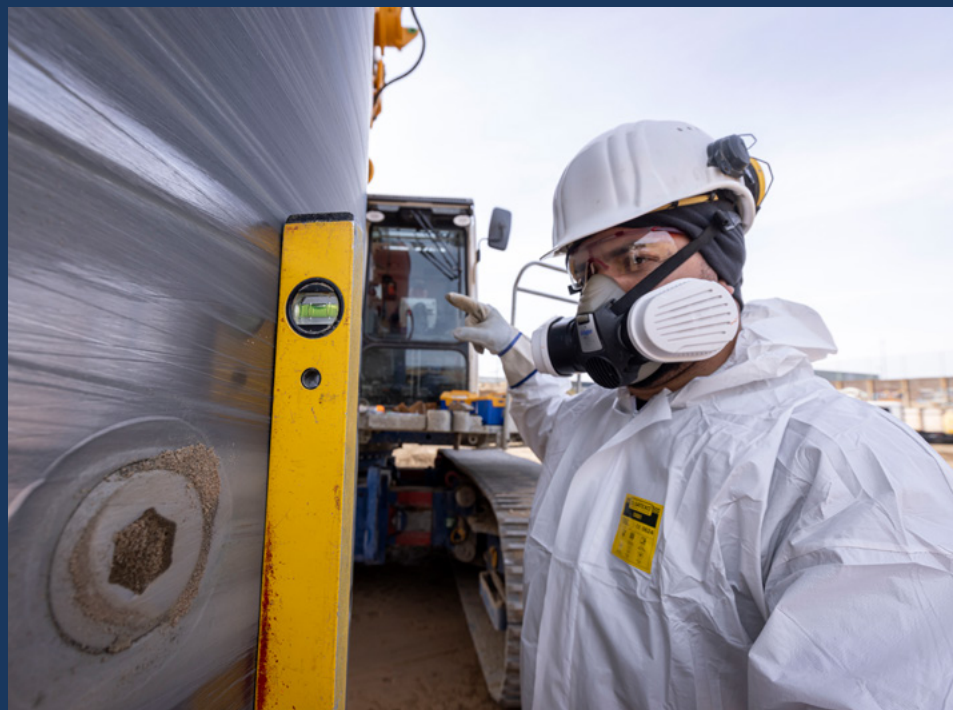
▲ Neigungskontrolle am Bohrrohr
