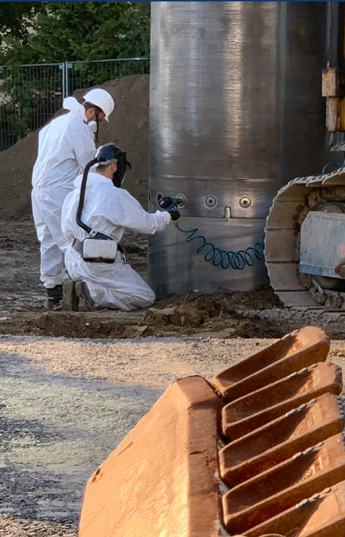
▲ Verschraubung Bohrrohre
