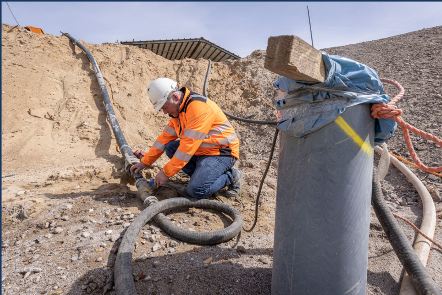
▲ Abstrombrunnen im Baufeld
