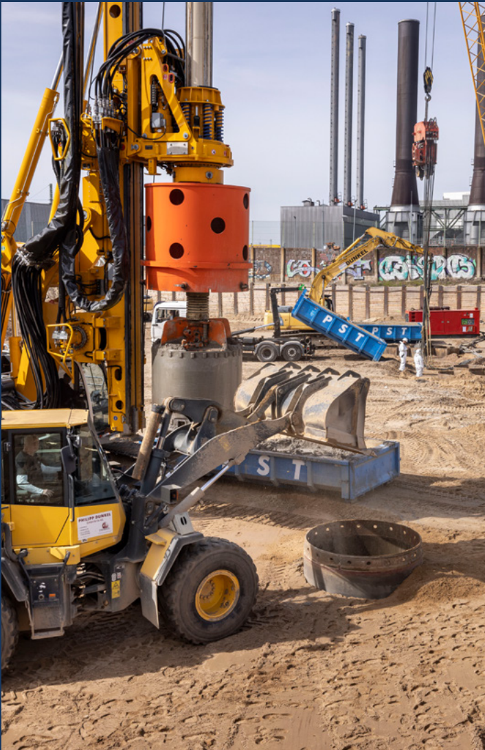
▲ Bohrlochverfüllung
