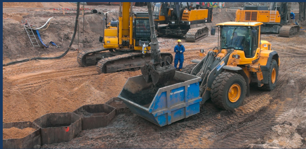
▲ Zweischalengreifer beim Wabenaushub
