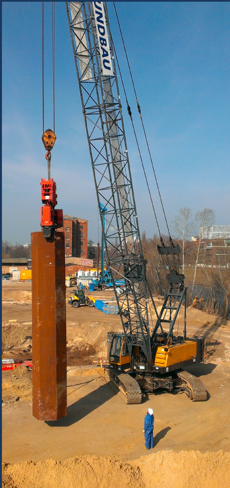
▲ Seilbagger mit 9 m langem Wabenelement
